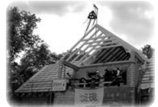
Richtfest auf dem Sportplatz Stubenrauchstraße
